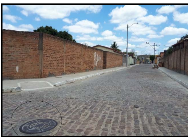
Poço de visita
