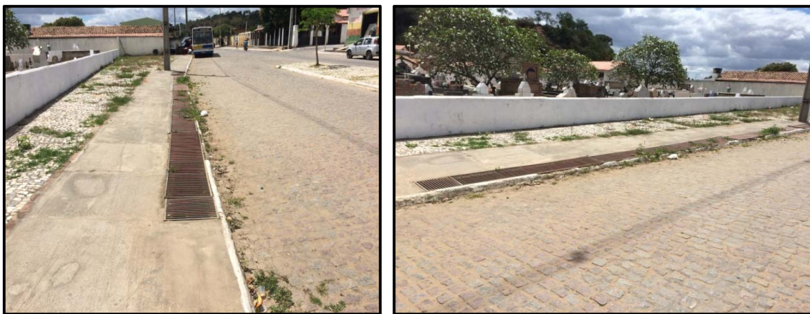
Figura 52 - Dispositivos de microdrenagem em Banzaê/BA
