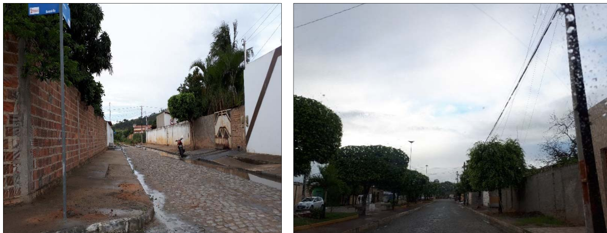
Figura 51 - Drenagem nas ruas e Praça em Banzaê/BA
