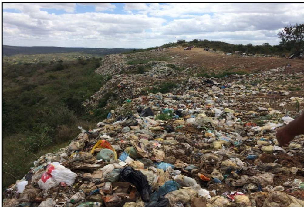
Figura 72 - Direcionamento dos materiais para os pontos mais baixos
