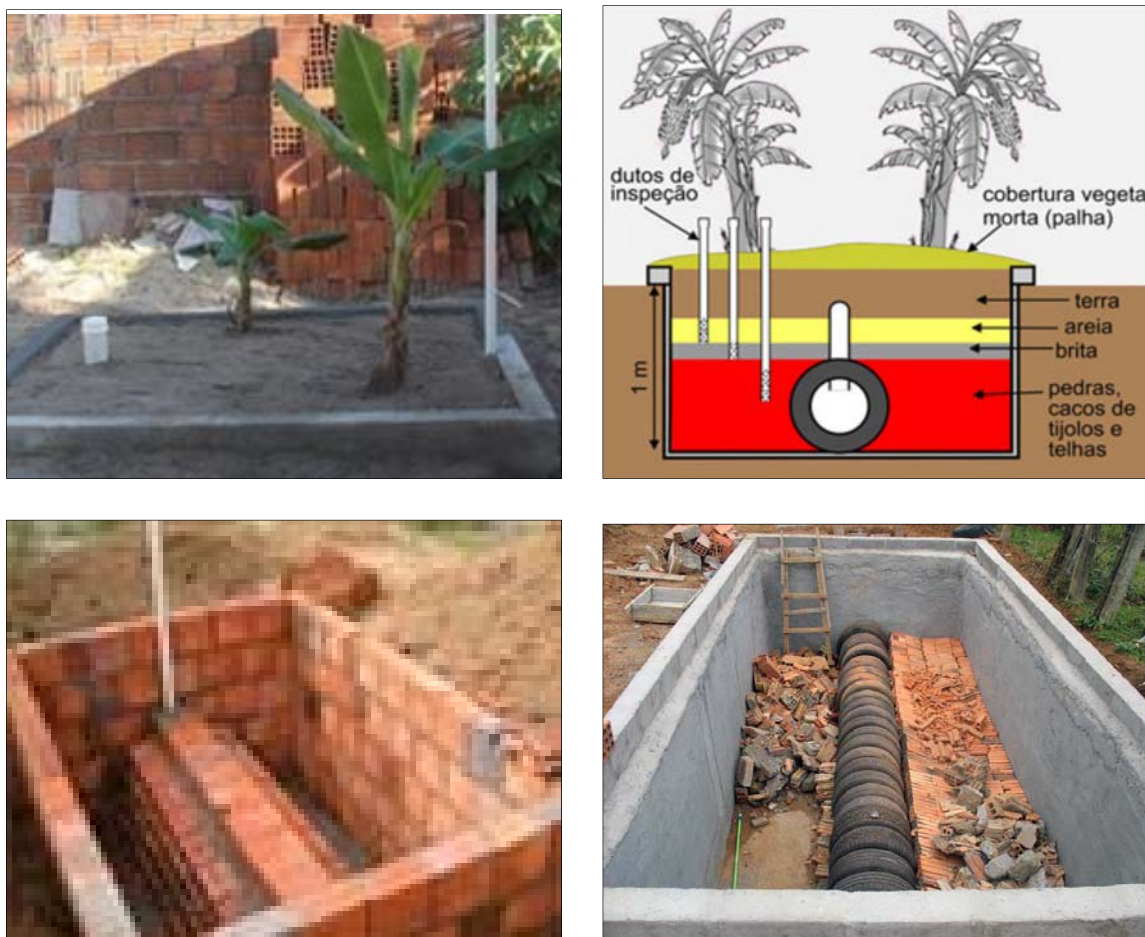
Figura 106 – Tanque de evapotranspiração
