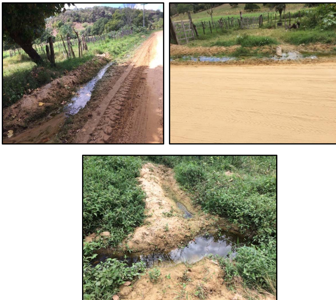
Figura 47- Pontos de extravasamento da ETE de Banzaê/BA
