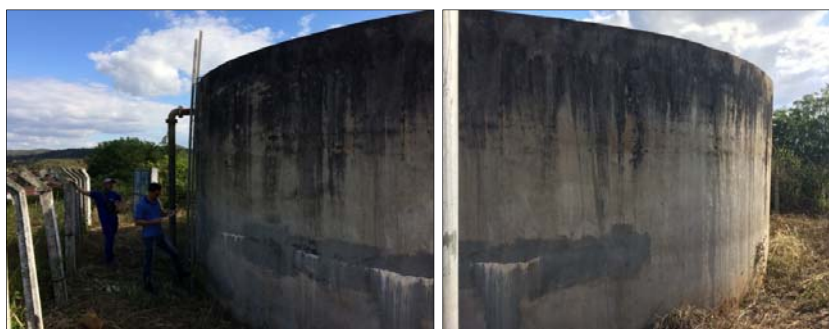
Figura 35- Reservatório apoiado de água distribuída de Banzaê/BA
