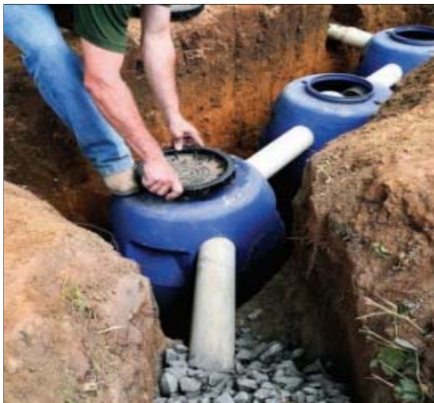
Figura 103 – Instalação das fossas sépticas econômicas
