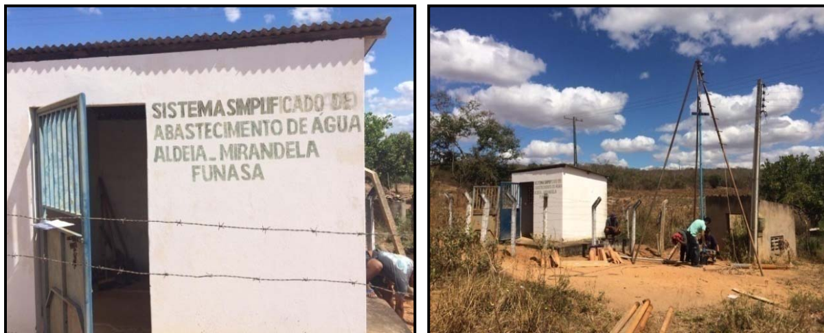
Figura 39- Estruturas de poços na área indígena
