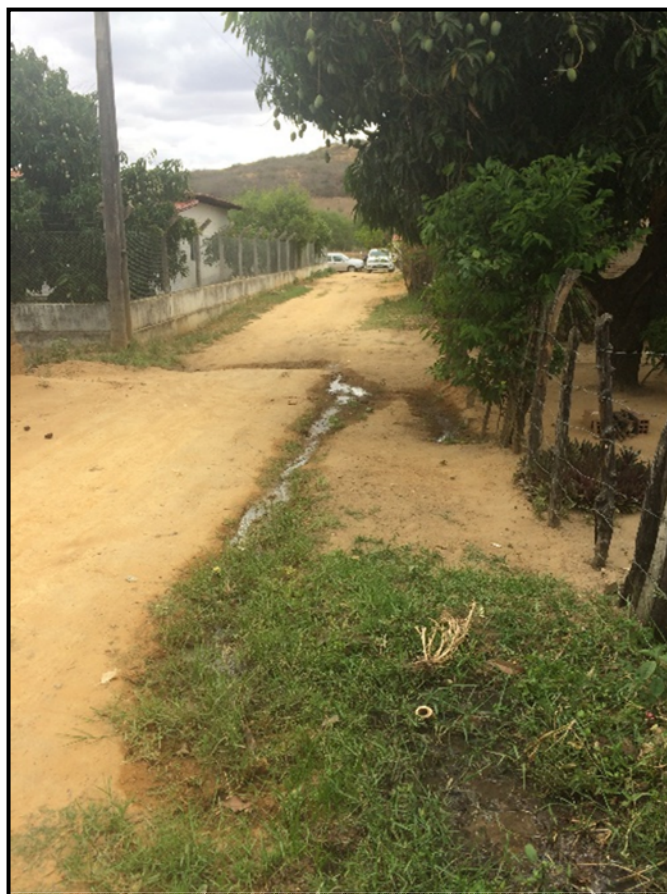
Figura 48 - Escoamento de esgoto a céu aberto na sede municipal de Banzaê/BA
