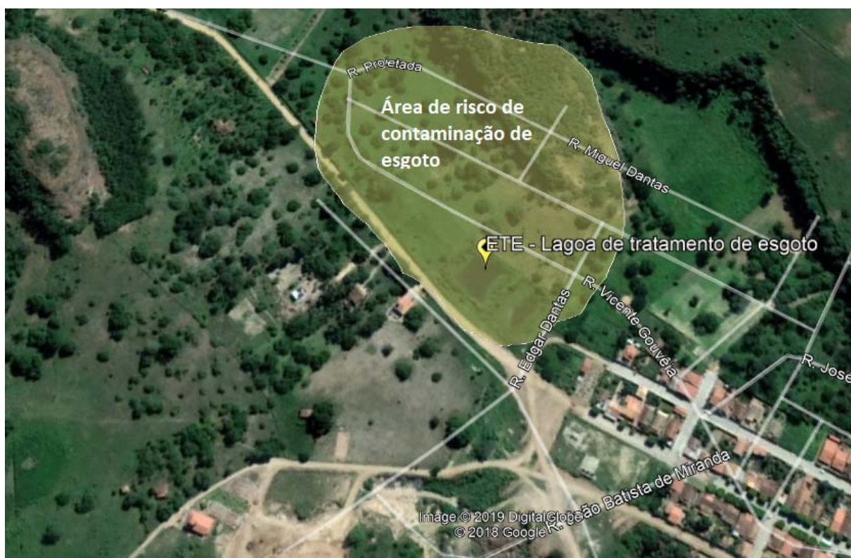
Figura 49 - Área de risco de contaminação por esgotomunicípio de Banzaê/BA
