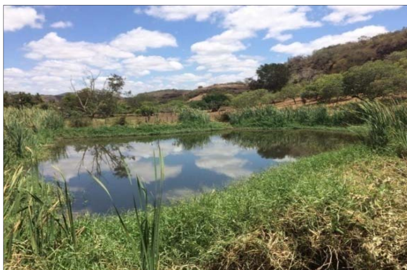
Figura 82 - Lagoa de Estabilização de Banzaê/BA
