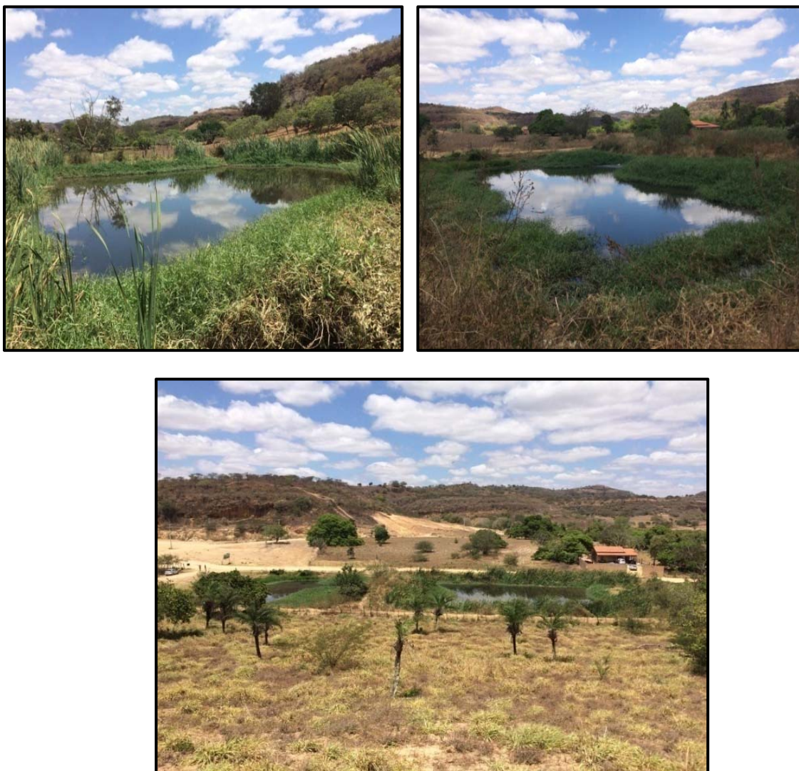
Figura 45 –Estrutura de tratamento de esgoto com lagoas - sede municipal de Banzaê/BA
