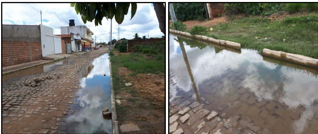
Figura 54- Pontos com problemas de acúmulo de água ou alagamento
